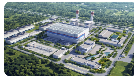
燃气发电项目
